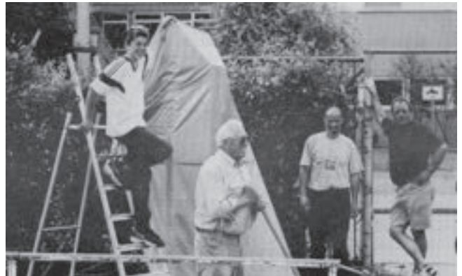
Geschafft, altes Kassenhäuschen abgerissen.
