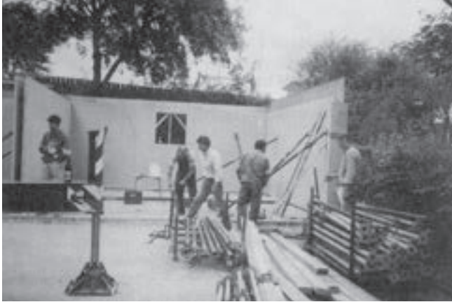
Bau eines Jugend- und Geräteraumes.
