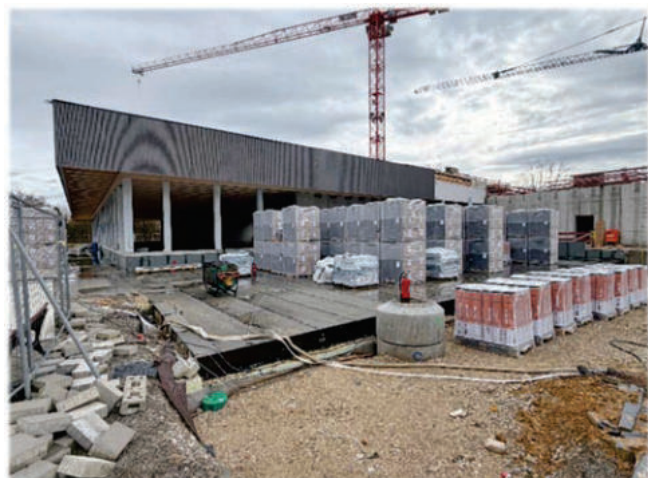
Ein Jahr nach dem Spatenstich steht das Richtfest unmittelbar bevor.
